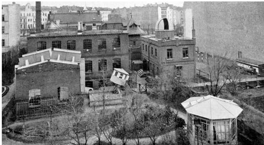
*Rückansicht der Bamberg-Werkstätten in Friedenau. Hier wurde unter anderem der 12-Zoll-Refraktor konstruiert. Rechts auf dem Dach: Observatoriumskuppel; Bildmitte: Schlingerturm für Marinekompass (Foto 1888; Feldhaus 1929, Abb. 47)*
