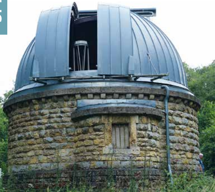
Oberhalb von Jena im Wald gelegen: die kleine Forststernwarte (Foto: Dr. Markus Bautsch)
